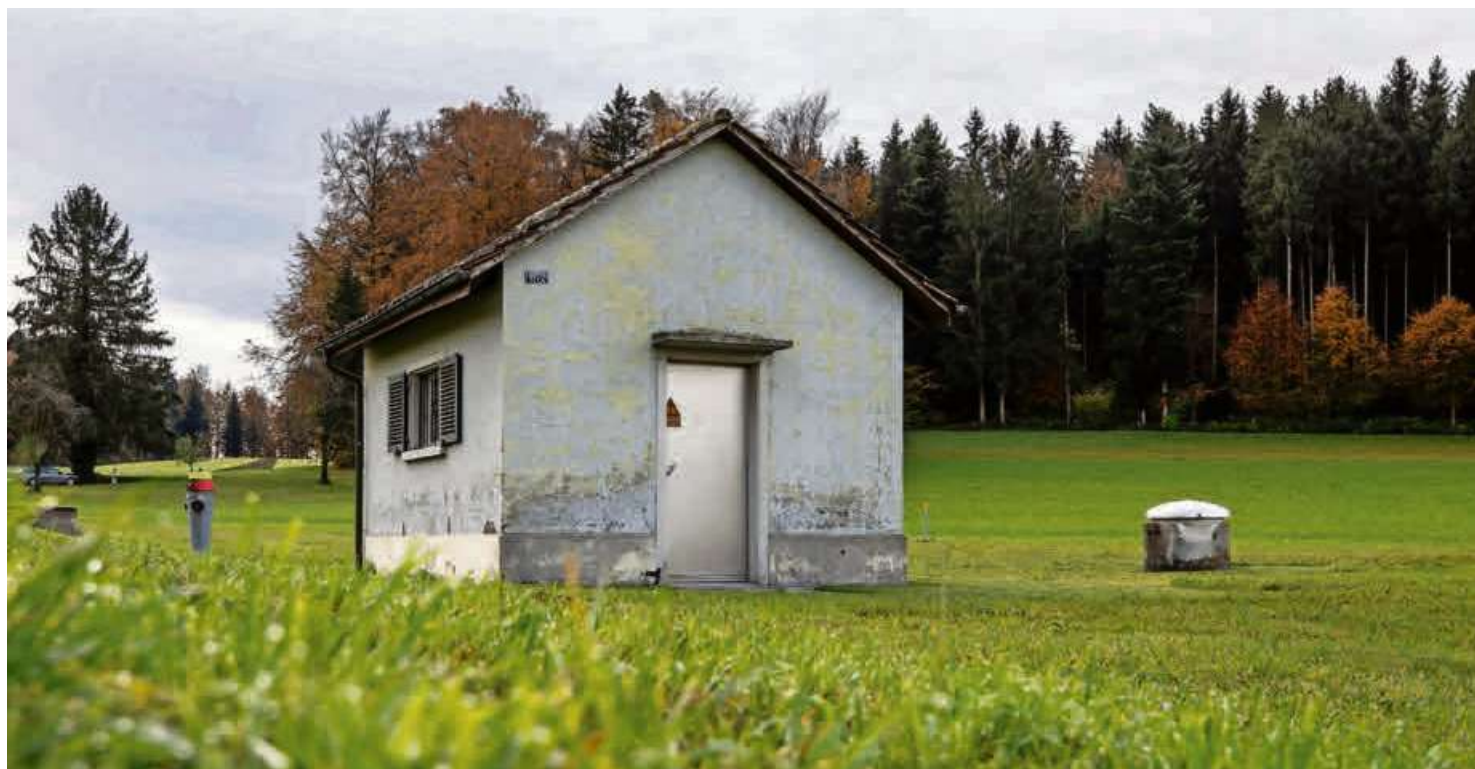
Die Energie Uster hat das Pumpwerk Freudwil bis auf Weiteres ausser Betrieb genommen. Foto: Christian Merz
